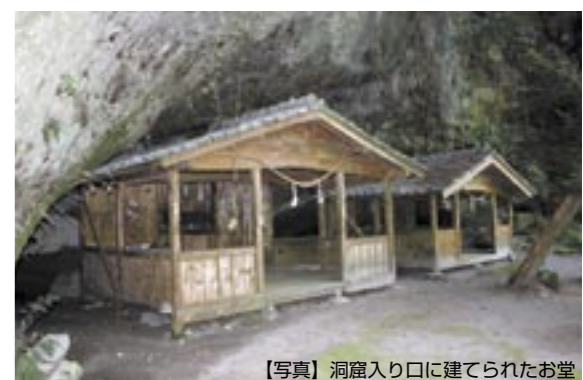
【写真】 洞窟入り口に建てられたお堂
