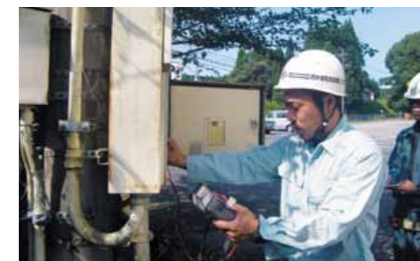
紙屋地区体育館での電気設備点検の様子
