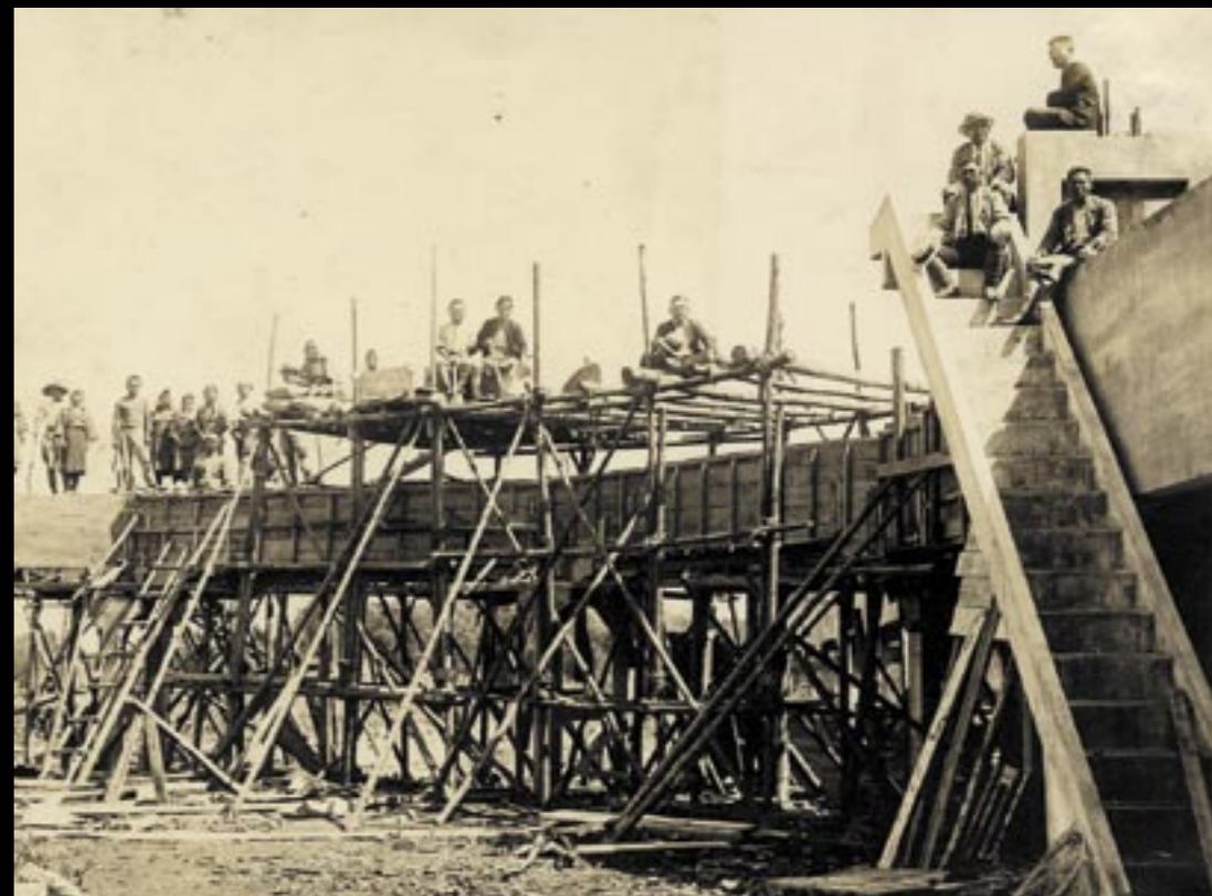
総延長18キロに及ぶ小林からの幹線水路工事。難工事で、幾度か挫折の危機に直面したといえます。
