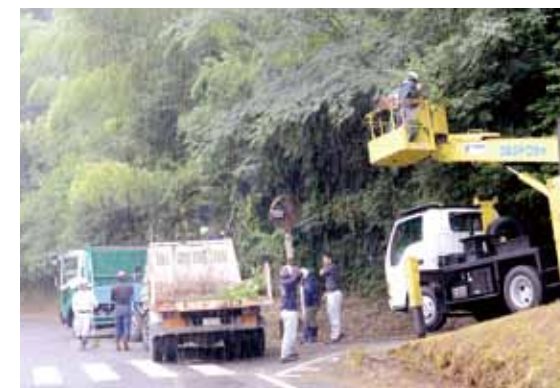
須木地区では、通学路の街灯に覆いかぶさっている木の枝などを伐採。高所作業車などで手際よく作業を進めていました
