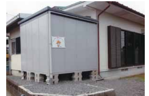
堤団地集会所敷地内に設置された倉庫。西堤区ではこれらの備品を地域のイベントなどで活用していく予定です
