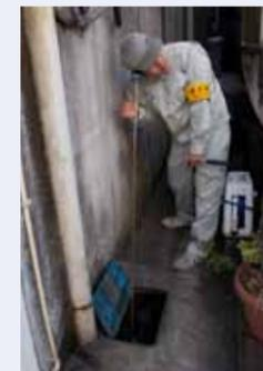
量水器(水道メーター)から音を聴く調査として昼間の9時～17時の時間帯に実施します。調査方法は「音聴棒」という長い棒を使用し、地下の水道管で漏水が無いかを聞き分けるものです。
