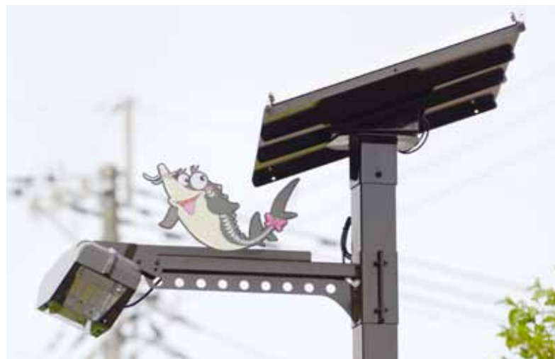
中心市街地に設置された多機能次世代ソーラーLED街路灯
