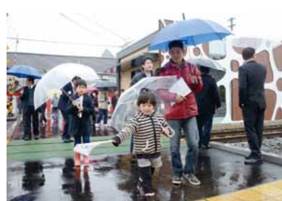
完成した通路を渡り初めする様子。今後、旧駅舎を取り壊し、28年度中に地域・観光交流センター(仮称)を建設する予定です
