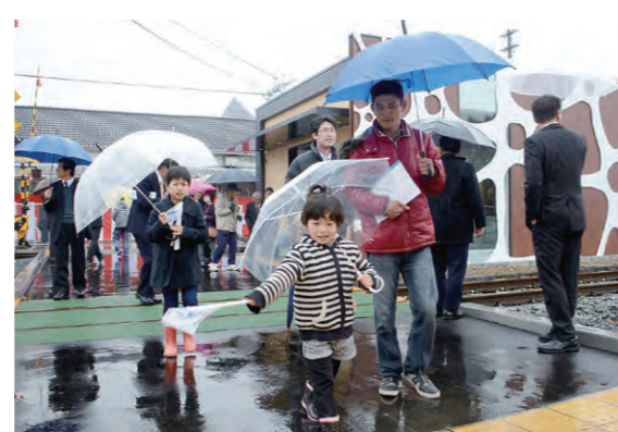
完成した通路を渡り初める様子。今後、旧駅舎を取り壊し、28年度中に地域・観光交流センター(仮称)を建設する予定です
