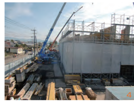
4 12月23日の工事の様子
