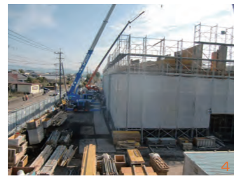
4 12月23日の工事の様子
