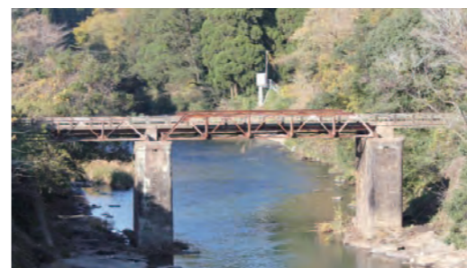
橋長 38.3 ㍎、水面からの高さ 7.5 ㍎ (国道 268 号線岩瀬橋から撮影)
