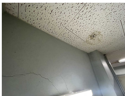
トイレ手洗い場
