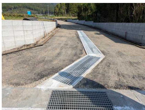
道路起点側（中央排水部）
