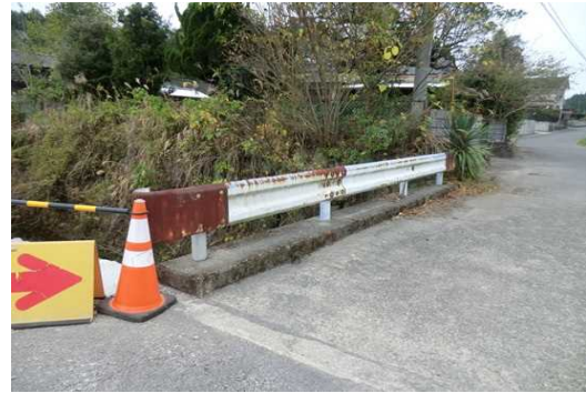
橋梁ガードレール
