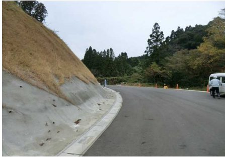
完成状況（隣接工区）
