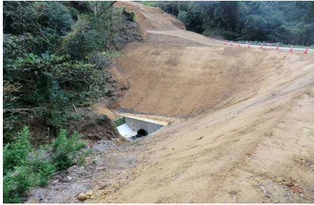
盛土・カルバート工
