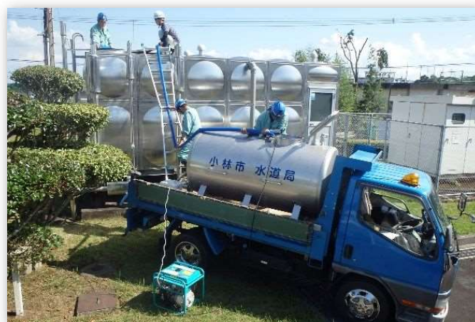
車載型給水タンク
