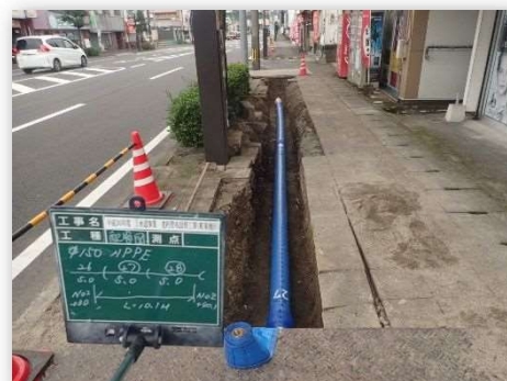
耐震管路の布設
