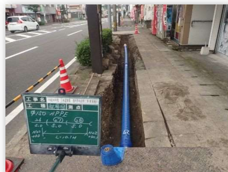
耐震管路の布設
