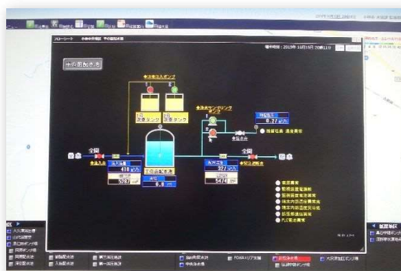
クラウド監視システム
