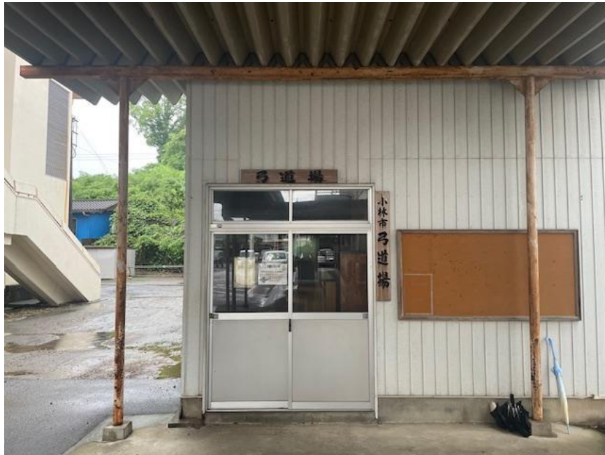
弓道場（市民体育館屋内 Wi-Fi 有り） 小林市細野 38 番地 1
