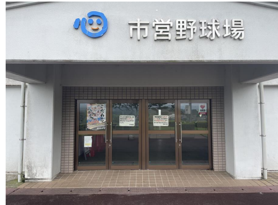
市営野球場（Wi-Fi なし） 小林市南西方 2087 番地
