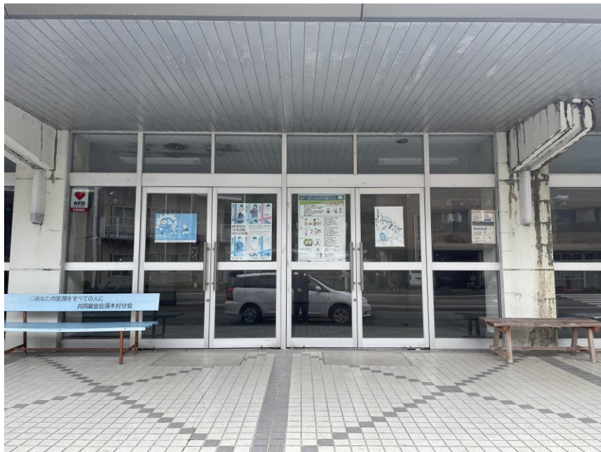
須木地区体育館（Wi-Fi なし） 小林市須木中原 1738 番地
