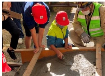
コンクリート舗装体験
