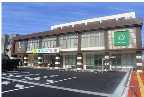
TENAMUビル 小林まちづくり株式会社
