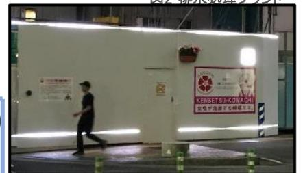
図3 仮囲いLED保安灯設置イメージ
