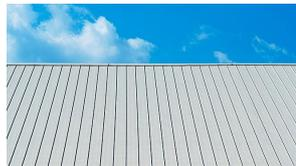
[事例]トラス構造 ガルバニウム鋼板嵌合立平葺き
