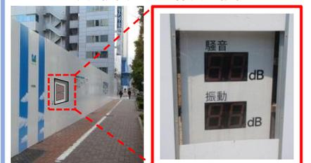
図4 仮囲い騒音振動計設置
