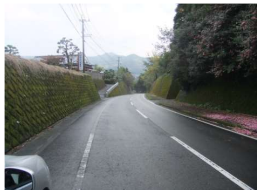
写真 2-2 烏帽子・釘松線「擁壁工」
