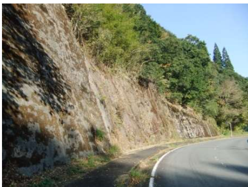
写真 2-1 夏木・九々瀬線「切土法面」
