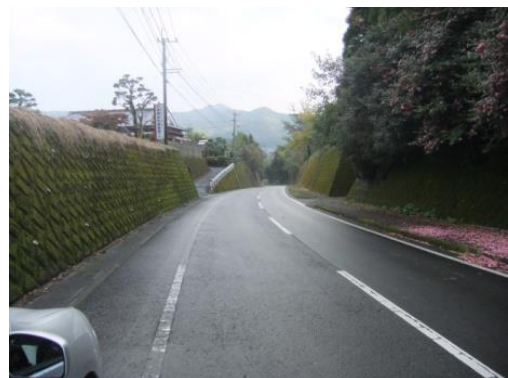
写真 2-2 烏帽子・釘松線「擁壁工」
