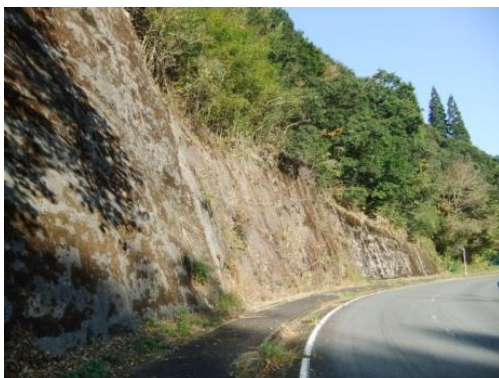
写真 2-1 夏木・九々瀬線「切土法面」
