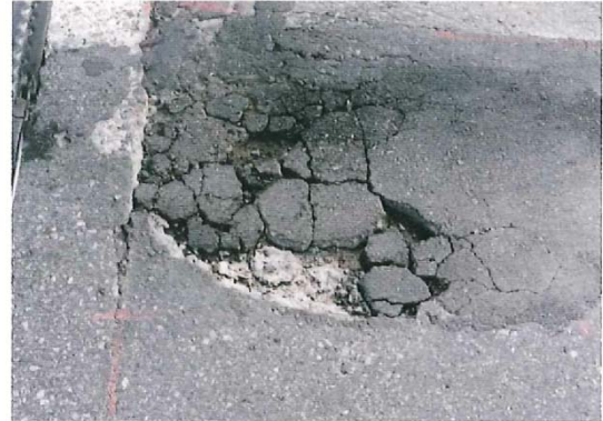
写真 2-2 路面の凹凸
