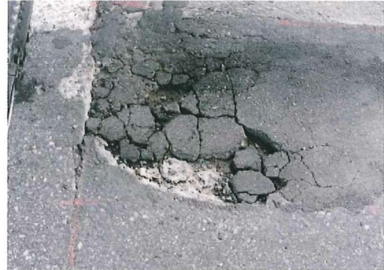
写真 2-2 路面の凹凸
