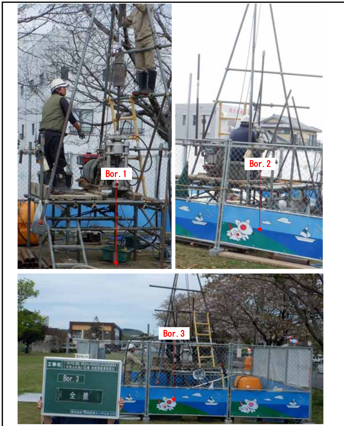
図3. 2. 1 ボーリング位置状況写真
