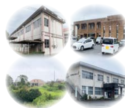
老朽化した公共施設
