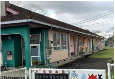
閉園前の野尻幼稚園園舎
