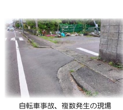
自転車事故、複数発生の現場
