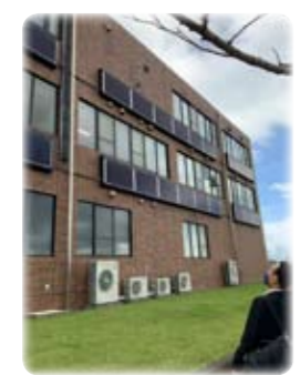
壁面に設置された太陽光パネル
