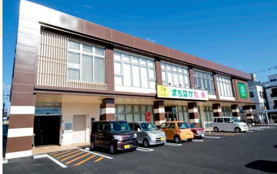
▲施設はテナムビル2階、木育キッズスペースがあった部屋をリフォームして開設
