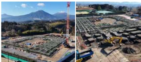
建設現場では既に基礎工事が行われ、122 本の杭打ち作業が完了しました。杭は、地中に最大で 29 ㍎の深さまで打ち込まれており、体育館を支える重要な基盤となります。
