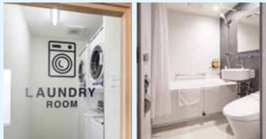
新設したランドリールームとユニットバスを入れ替えた浴室
